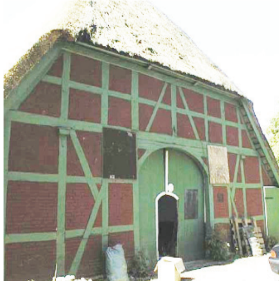
01023 Modernisierung Richthofenstraße, Holtenuau | Architekten BSP, D. Hellwig Bordesholmer Fachhallenhaus, ältester Profanbau in Kiel
