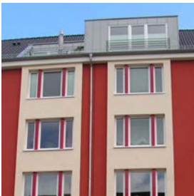
05014 Modernisierung Holtenauer Str. 218 - 224, Kiel | WoGe Kiel | Architekten BSP, D. Hellwig Modernisierung von 50 Wohnungen aus den fünfziger Jahren und Dachausbau
