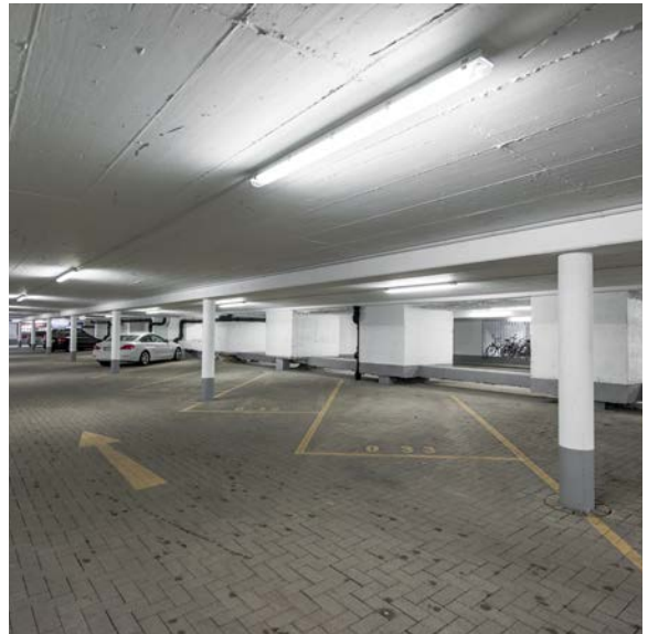
Tiefgaragenebene neu mit Pfahlkopfplatte
